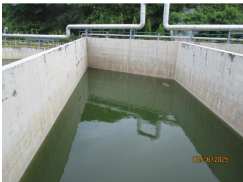
รูปที่ 3-10 บ่อพักน้ำทิ้งฉุกเฉิน
