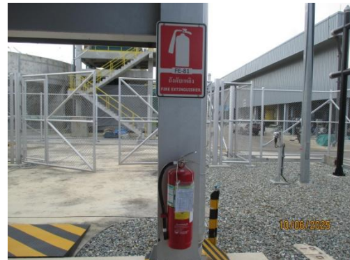
รูปที่ 3-48 อุปกรณ์ดับเพลิงชนิดผง (Powder Extinguisher) บริเวณสถานีควบคุมก๊าซธรรมชาติ
