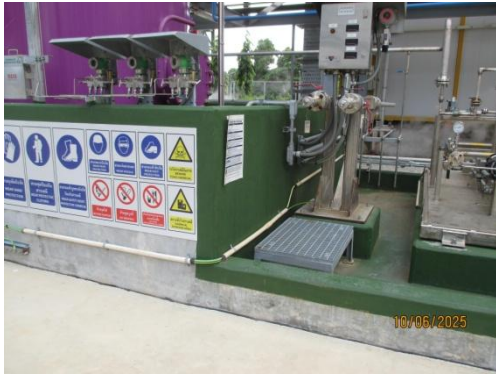
รูปที่ 3-33 เขื่อน (Dike) ล้อมรอบ บริเวณพื้นที่รองรับถังบรรจุน้ำมัน
