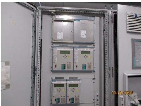
รูปที่ 3-49 ระบบป้องกันทางไฟฟ้า (Relay) บริเวณเครื่องกำเนิดไฟฟ้า
