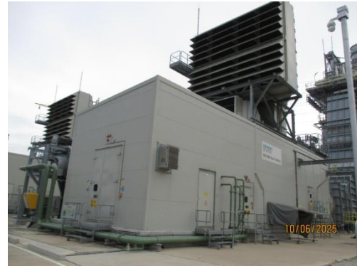
รูปที่ 3-28 อุปกรณ์คลุมเครื่องจักร เพื่อช่วยลดเสียงดัง
